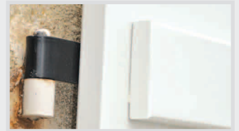
PLIAGE DES PENTURES : adaptation aux gonds existants
