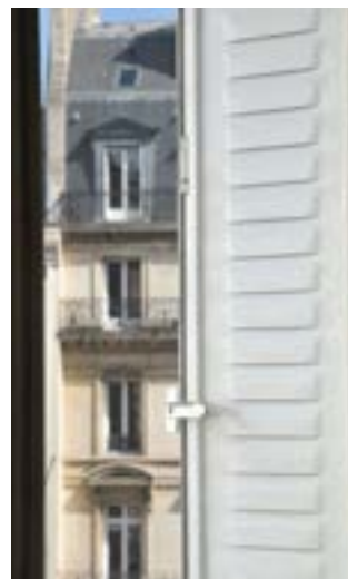
PERSIENNE se repliant à l'intérieur
